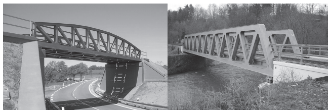
Obr. 3 a 4 Príklady priehradových konštrukcií použitých na mostoch. Zdroj: Railway bridges. Top Con Service [online]. 1992-2011 [cited. 02.19.2012]. Dostupné na: http://www.topcon.cz/reference/railway-mosty.htm
